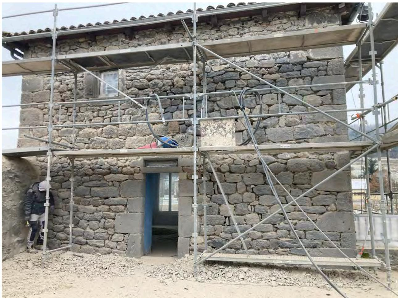
Pour le gros oeuvre, démolitions intérieures des planchers, cloisons et reprise des canalisations en dallage. Un plancher béton sur les deux niveaux sera fait. Bouchage partiel de la porte du sous sol et enduit pierres vues sur les façades extérieures.
