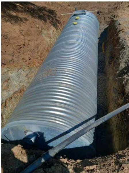
Cuve en acier galvanisé, d'un volume de 50 m<sup>3</sup>, d'une longueur de 10,20m ,
